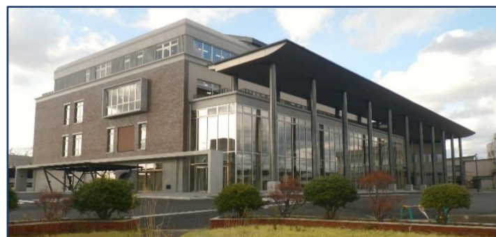
庄内町役場 令和2年完成
