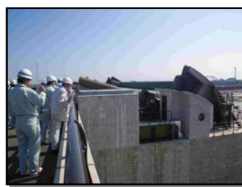
大河津可動堰
