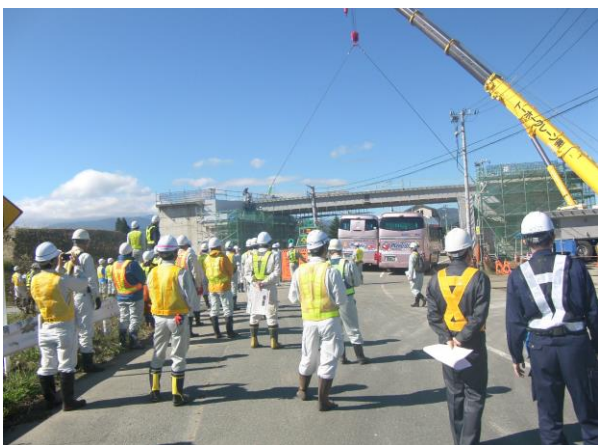
橋梁技術研修(鋼橋・PC橋)
