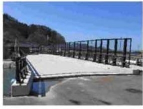
市道沢山木揚場線 岩川橋 (鶴岡市) 橋梁架替 積算支援
