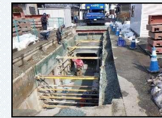
村山野川左岸第一排水区雨水函渠布設(東根市)
