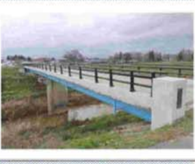
町道中里西町線 内方橋 (川西町) 橋梁補修 積算支援
