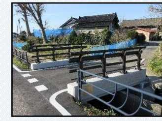
町道猪子8号線七左工門橋(三川町)
